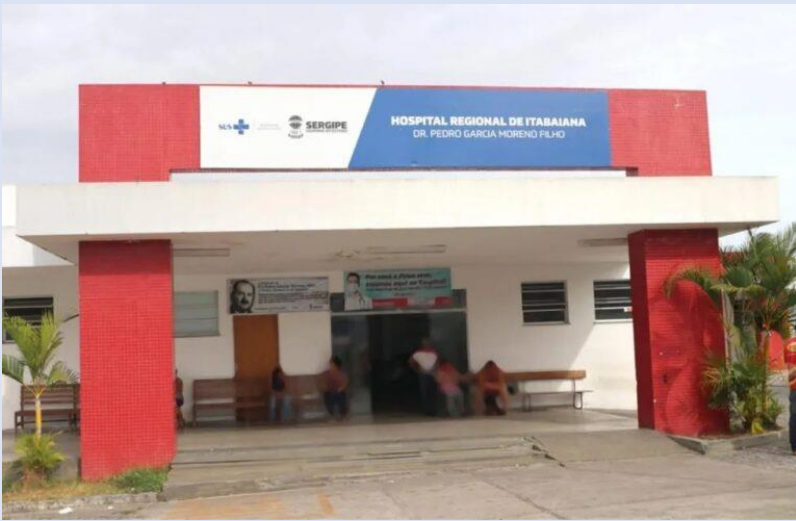
Ação civil pública foi ajuizada pelo MPT-SE após constatar irregularidades no Hospital Regional de Itabaiana
